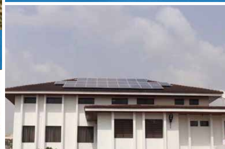
Ghana Sistema PV de 10 KW
