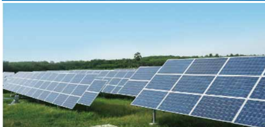
Proyecto Saraburi Tailandia
